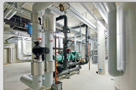
Gebäudetechnik Building Technology
